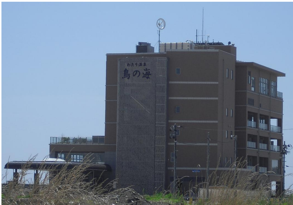
図5 平成24年8月29日から運用が開始された1kWのレンズ風車
