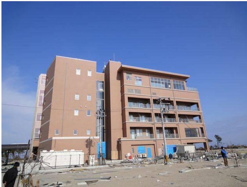
図2 レンズ風車の設置予定建造物、宮城県亶理町
